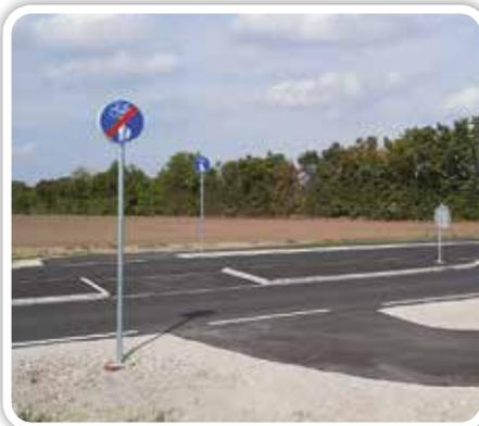
Die Gesamtlänge der neuen L 148 beträgt 575 Meter und die Fahrbahnbreite beträgt im Regelfall 6,5 Meter. Die Oberflächenwässer werden über beidseitige Versickerungsmulden versickert. Für die Errichtung der neuen Straße wurden ca. 7.000 Kubikmeter Oberboden und Lockerboden abgetragen und durch ca. 7.600 Kubikmeter ungebundenes Material aufgebracht. Die Fahrbahn wurde dreilagig in einer Gesamtstärke von 19 Zentimeter asphaltiert.
